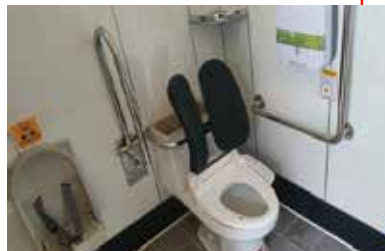
남자 장애인실 자동물내림 비데 양변기 안전손잡이 양변기 등받이 영유아보호의자 안심비상벨 장애인용 세면대
