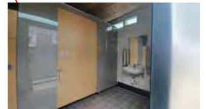
장애인용 칸막이 출입문 유효폭 0.9m 이상 출입문 높이 2.0m 이상 슬라이딩 도어 적용 칸막이 내부 1.6m X 2.0m 이상 확보 전면 활동공간 1.4m X 1.4m 이상 확보
