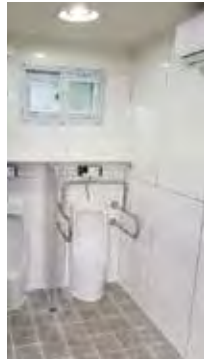
단열기준 층족 벽체 및 창호 미끄럼방지 자기질 타일 시공 실내 에어컨, 자동온도조절 라디에이터 기본 적용
